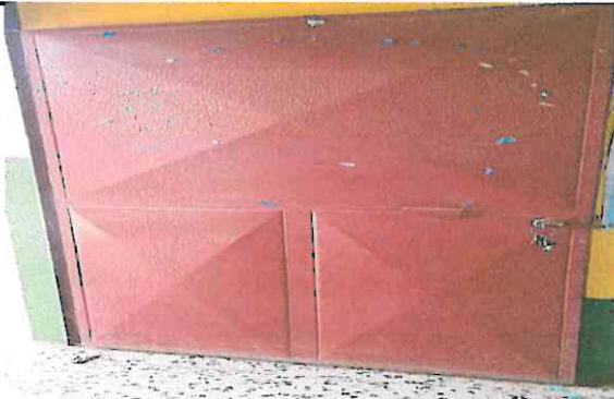
Foto 3: Mantenimiento de puertas
