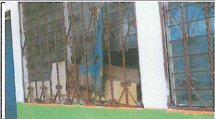
Foto13:Mantenimiento de balcones lijado y pintura
