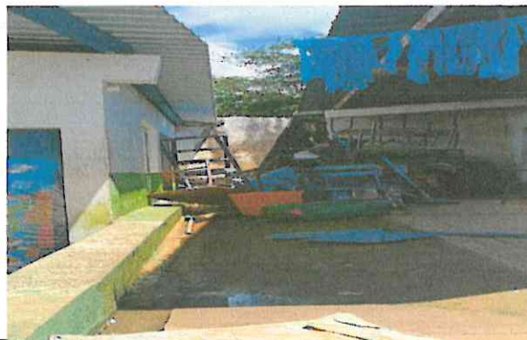
Foto 14: Reparacion de coladera, frente el salon subiendo las gradas
