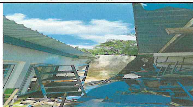
Foto 8: Reparación de canales y colocación de lámina
