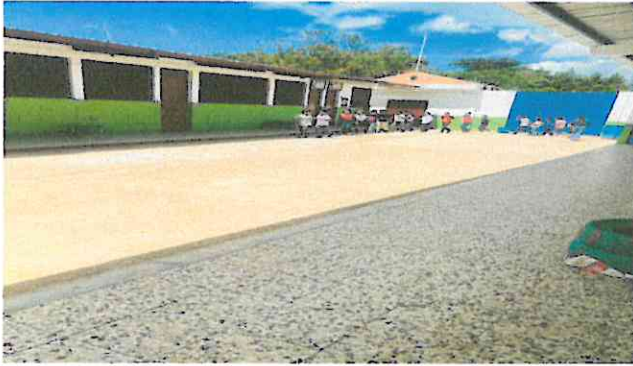
Foto1: Instalacion de techo en porton principal
