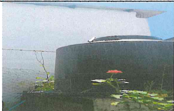
Foto 15: Reparación de tubería y accesorio de depósito de agua
