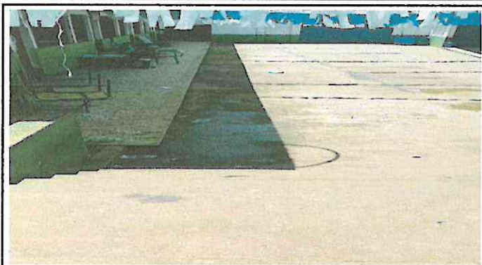
Foto 7: Reparación de cuneta de concreto
