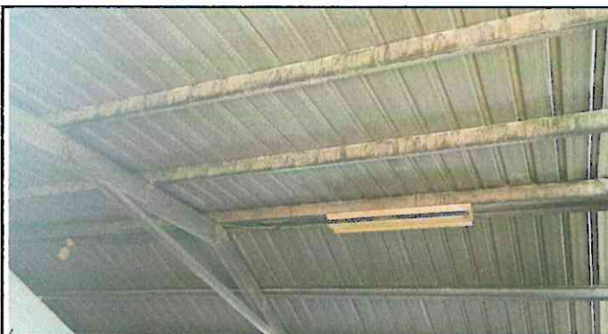
Foto 9: Mantenimiento de costaneras y sustitución de lámparas
