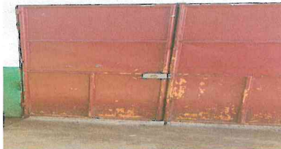
Foto 16: Mantenimiento a estructura: lijado, cambio de tubo, cepillado, aplicación de pintura
