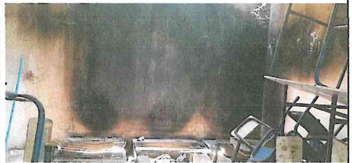
Foto 4: Reparacion de chimena
