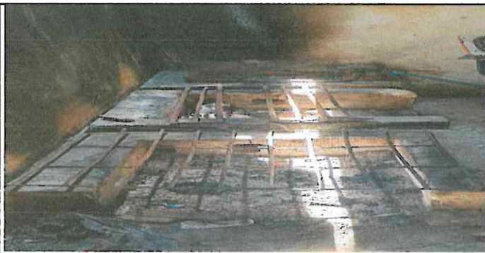
Foto 5: Reparación de estufa rural
